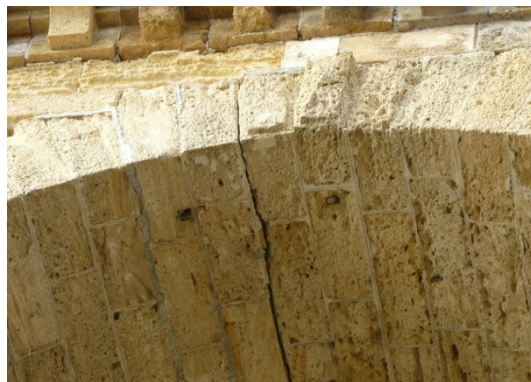
Basculement de la pile culée
